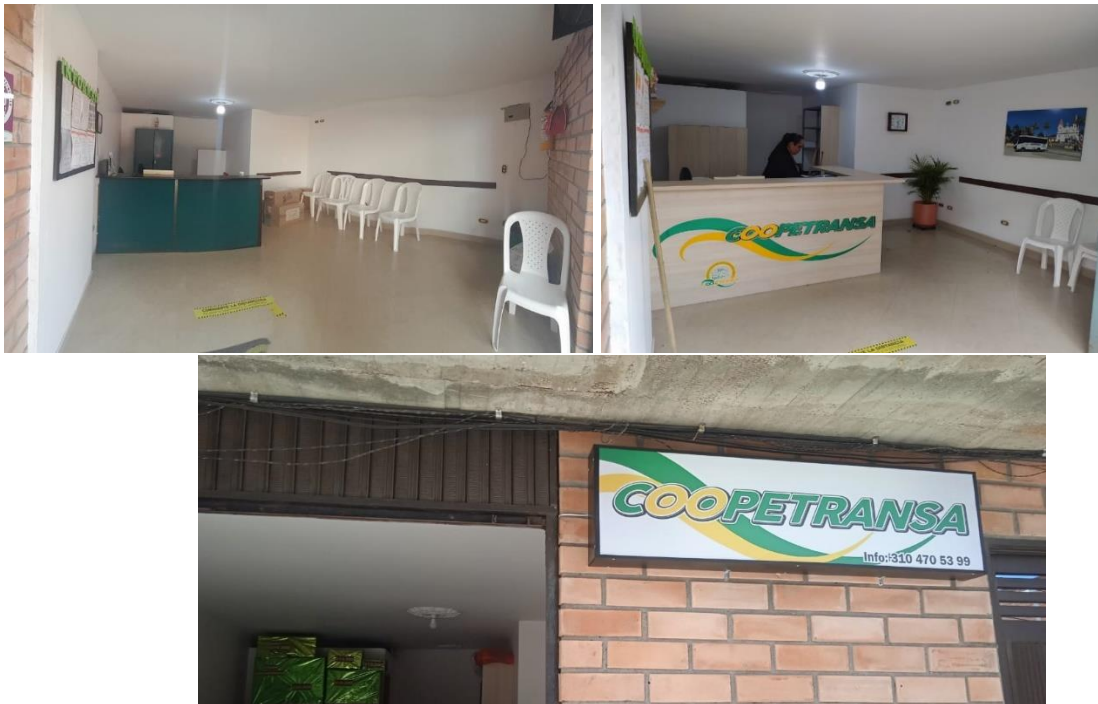
Mejoramiento y reparación de la taquilla e instalación del aviso institucional.
